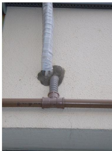
**Figura 3** - Saída do dreno do ar para conexão dos tubos de PVC coletor de água.
